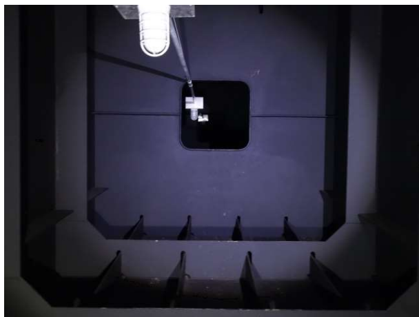
강박스 거더 내부 전경
