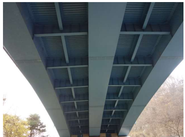
강박스 거더 외부 전경
