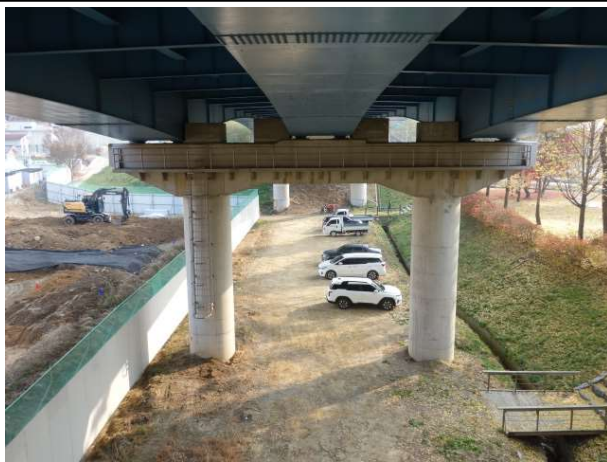
P2 교각 점검로 및 점검사다리 전경
