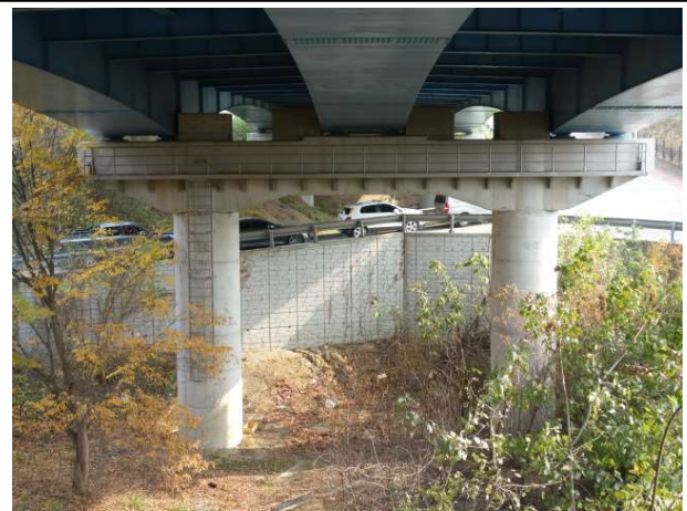
P4 교각 점검로 및 점검사다리 전경
